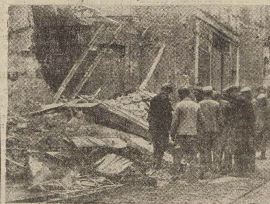
Bu sabah Aksaray yolunda tramvay hattı üzerine yıkılan duvarlar temizle nirken
